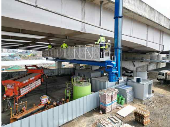
굴절차를 이용한 근접조사
