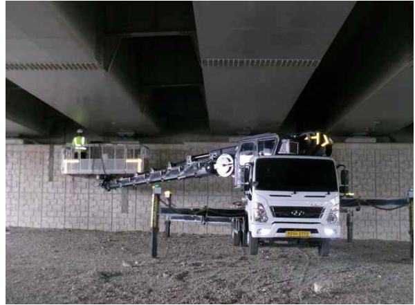
고소점검차를 이용한 근접조사
